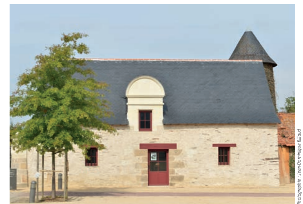
Le bâtiment et sa lucarne reconstituée.
