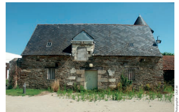
Le bâtiment et sa lucarne transformée. Photographie avant travaux.
