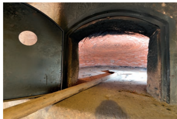
Vue sur l'intérieur du four à pain, sa sole et sa voûte en briques réfractaires.
