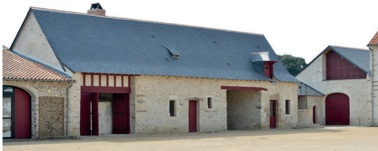
Façade sur cour de l'ancien logement et de la boulangerie (façade à pan de bois restituée), aile sud de l'ancien manoir
