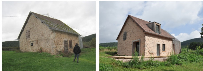
Vue générale - Sud - Avant/Après
