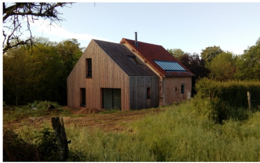
Vue générale - Nord
