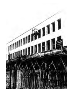
Chantier de construction de la Trésorerie Générale dans les années cinquante
