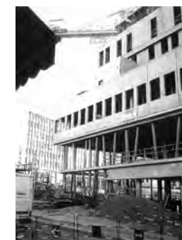
Chantier de construction de l'immeuble E.X.T.G. en 2001
