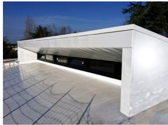
Éclairage zénithal en toiture
