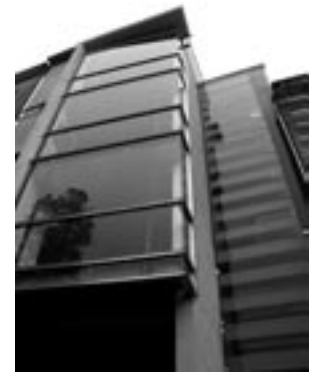
Façade côté jardin le jour
